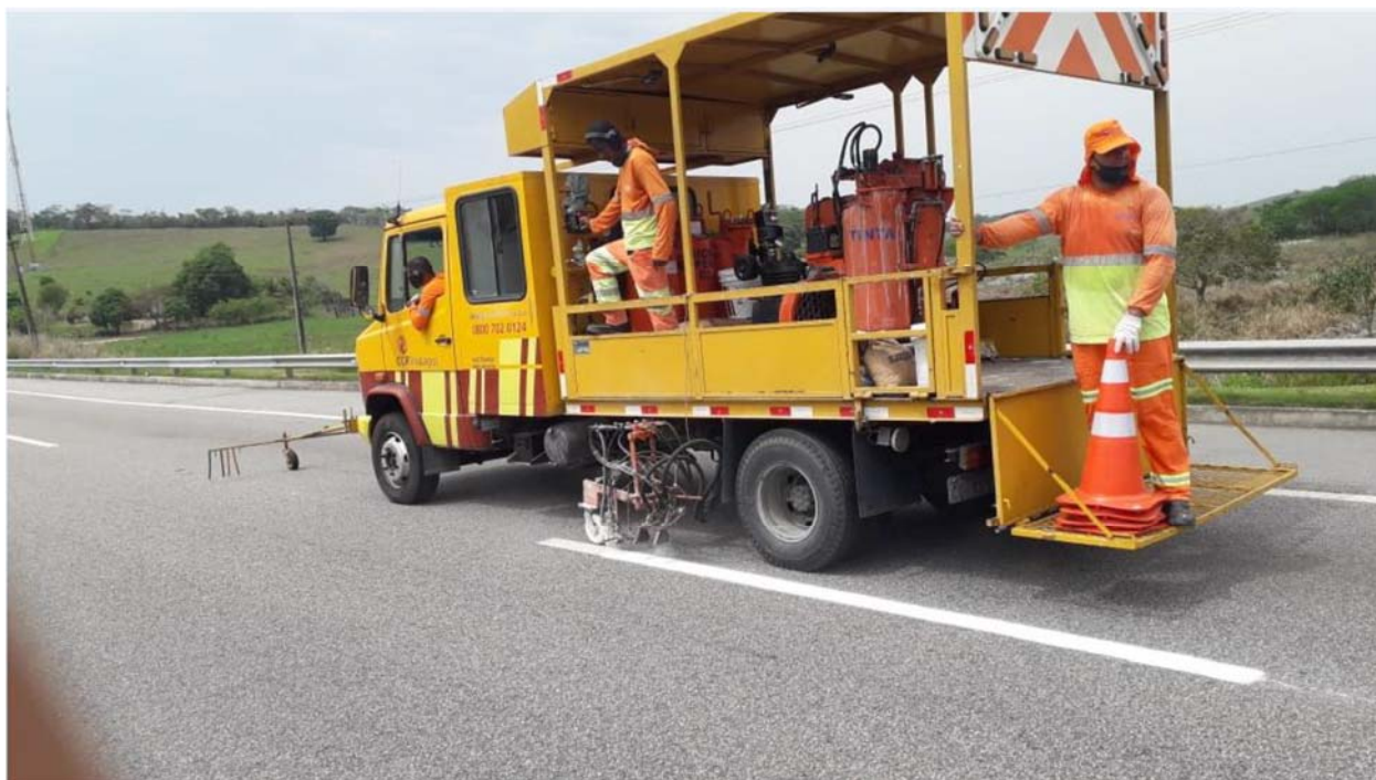
FOTO 05 - Pintura de faixas – Km 24+000 Norte – F2
