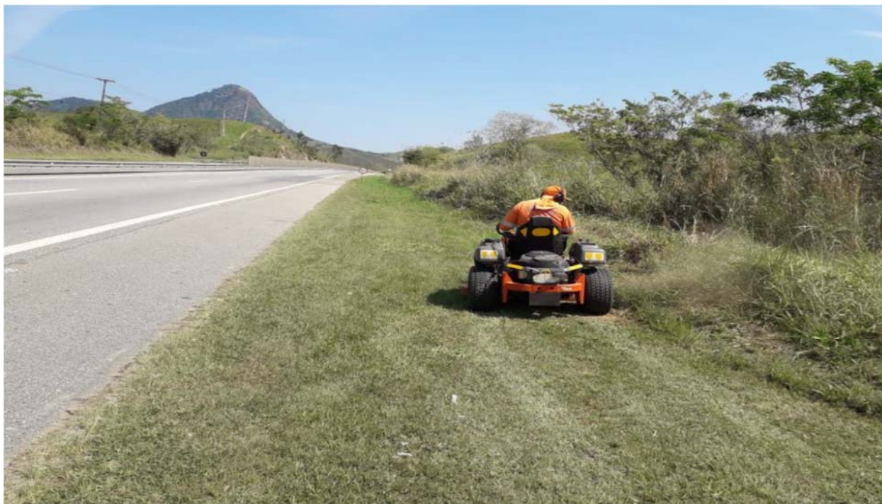
FOTO 17 – Roçada mecânica Km 15+500 Sul - F1
