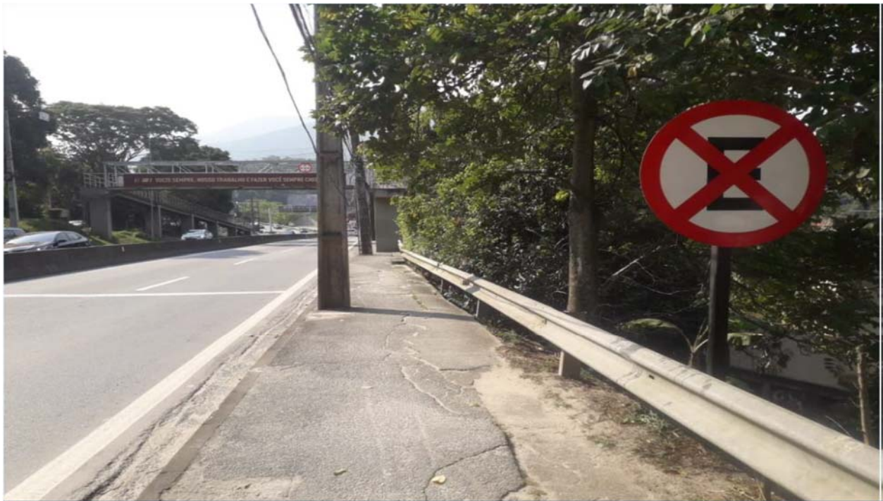
FOTO 07 - Limpeza de placa - Km 0+500 Sul – F2
