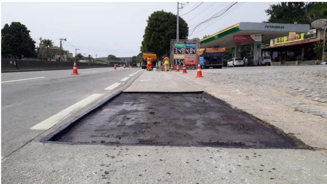
FOTO 02 – Acostamento – Reparo profundo - KM 13+500 Norte – F2
