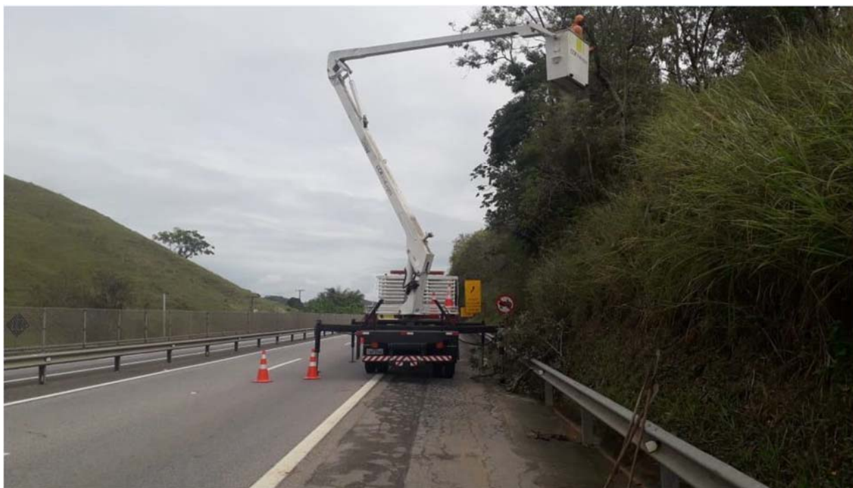
FOTO 19 – Poda de árvores Km 7+500 Sul – F1
