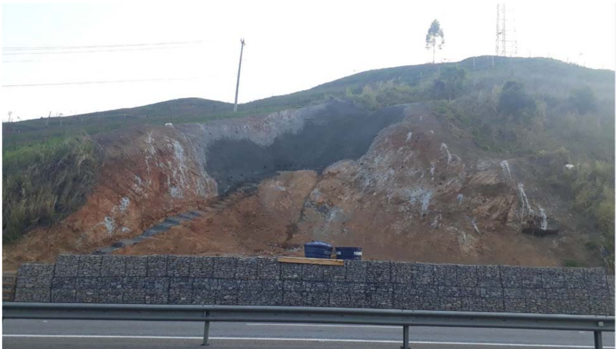
FOTO 22 – Obra de recuperação do Talude Km 9+760 – F2
