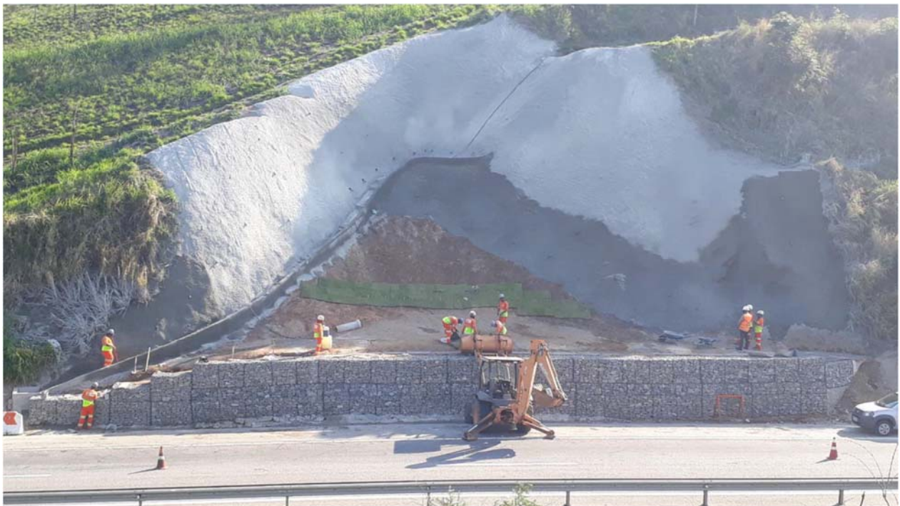
FOTO 24 – Obra de recuperação do Talude Km 9+760 – F4
