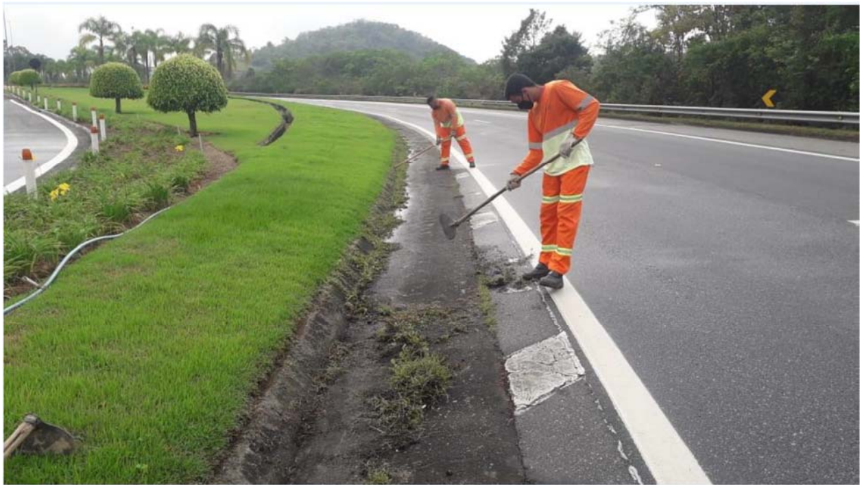
FOTO 11 – Limpeza sarjeta - Km 23+000 Norte – F1
