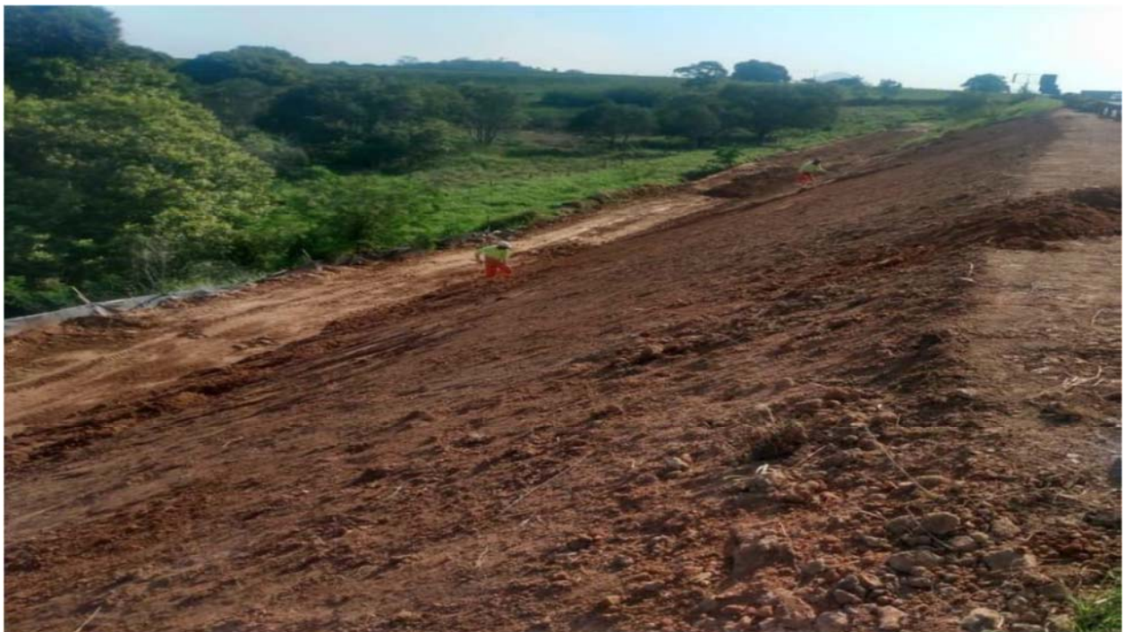
FOTO 26 – Obra de recuperação do Talude Km 30+080 – F2
