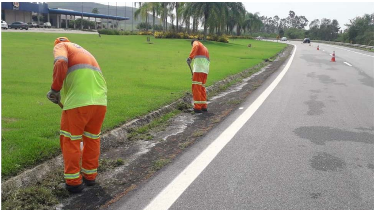
FOTO 12 – Limpeza sarjeta - Km 23+000 Norte – F2
