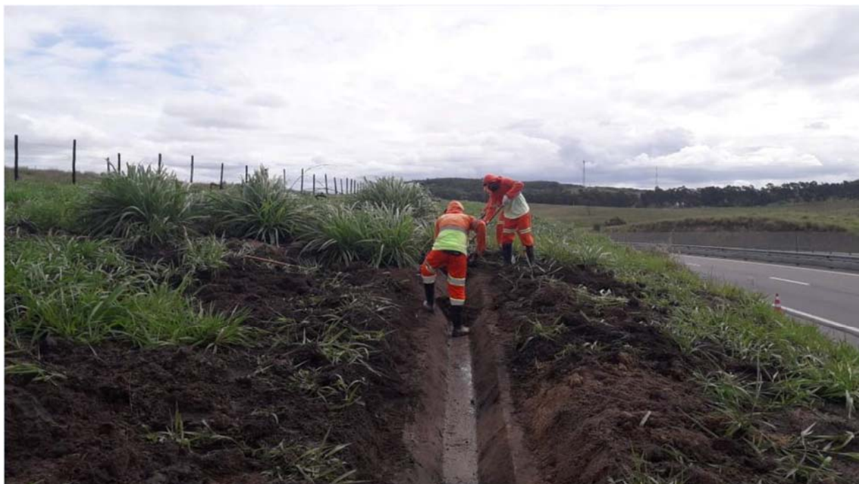
FOTO 14 – Limpeza canaleta - Km 45+300 Norte F2
