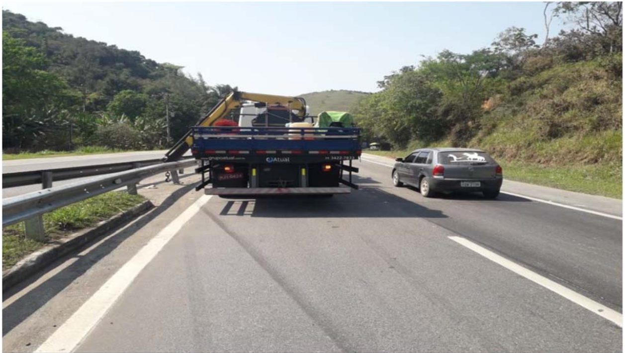
FOTO 09 - Dispositivo de Segurança - Km 01+900 Norte - F1.
