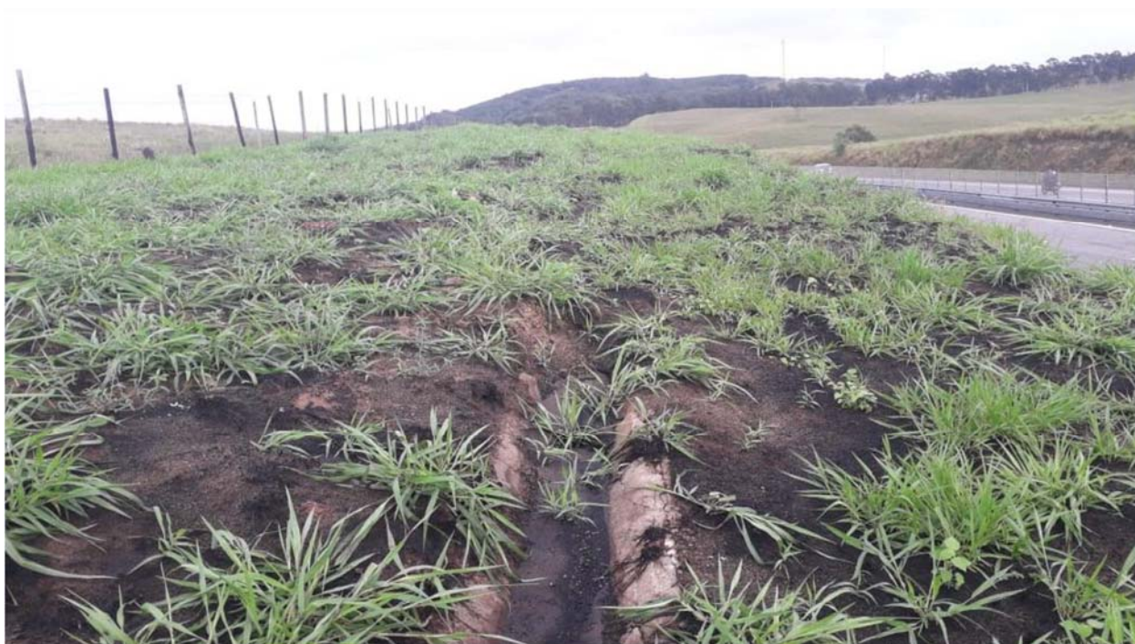
FOTO 13 – Limpeza canaleta - Km 45+000 Norte F1
