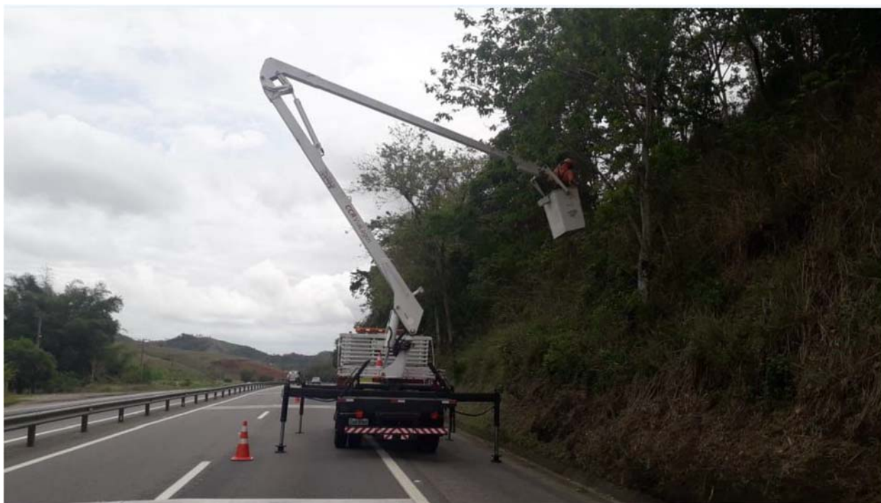
FOTO 20 – Poda de árvores Km 7+500 Sul – F2
