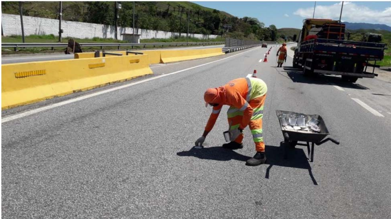
FOTO 08 - Implantação de Tachas - Km 09+300 Sul – F1
