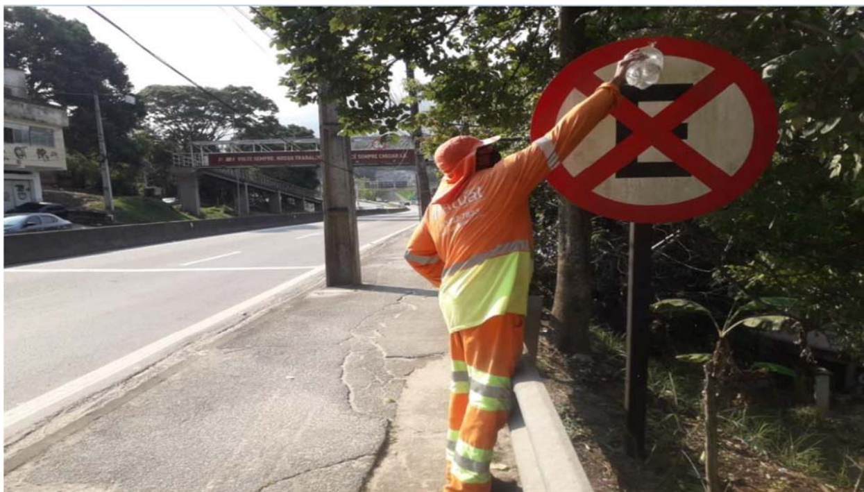
FOTO 06 – Limpeza de placa - Km 0+500 Sul – F1
