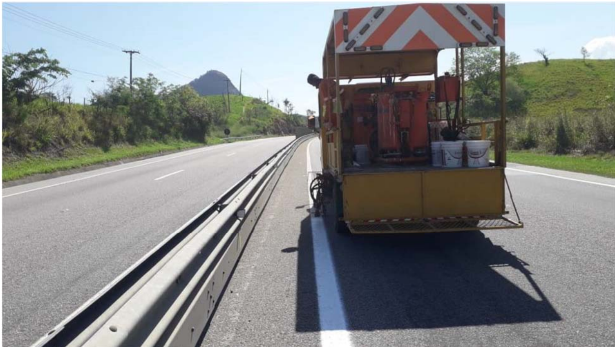
FOTO 04 – Pintura de faixas - Km 11+200 Sul – F1
