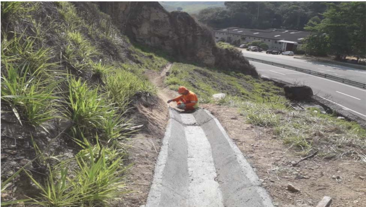
FOTO 16 – Reparo de canaleta - Km 02+500 Norte – F2
