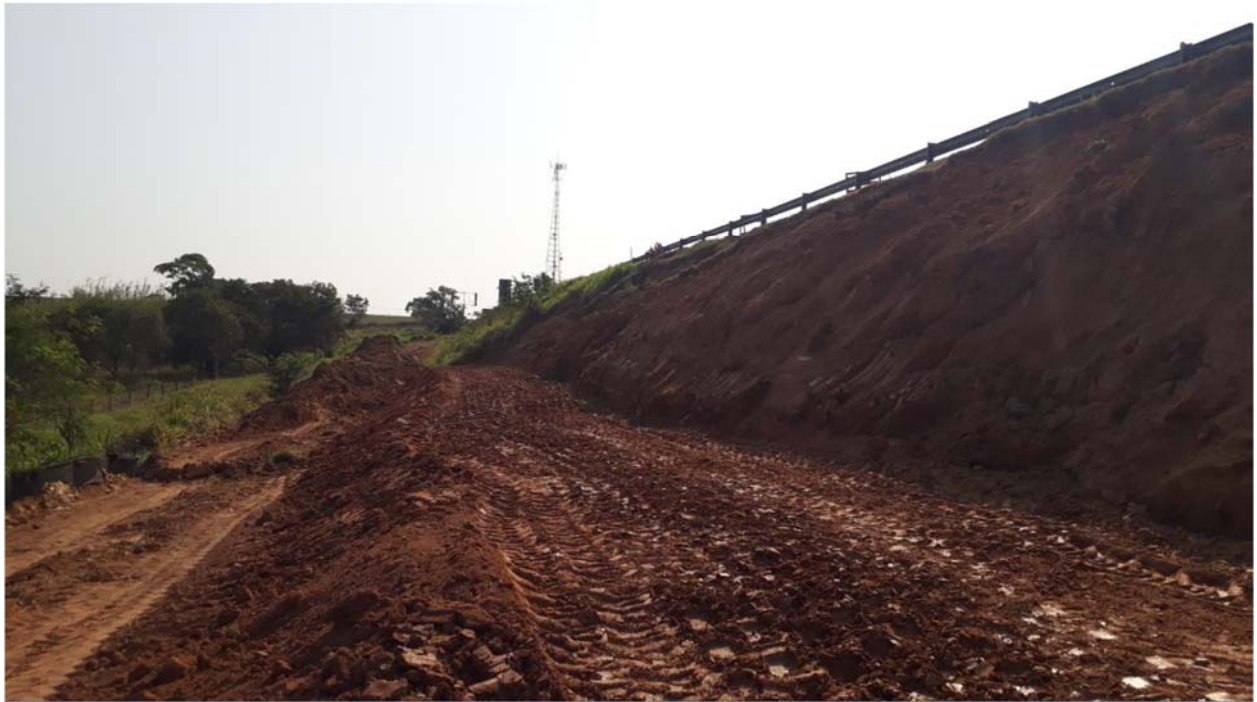
FOTO 25 – Obra de recuperação do Talude Km 30+080 – F1
