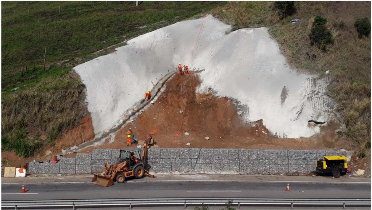
FOTO 23 – Obra de recuperação do Talude Km 9+760 – F3
