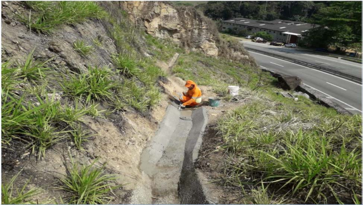
FOTO 15 – Reparo de canaleta - Km 02+500 Norte – F1
