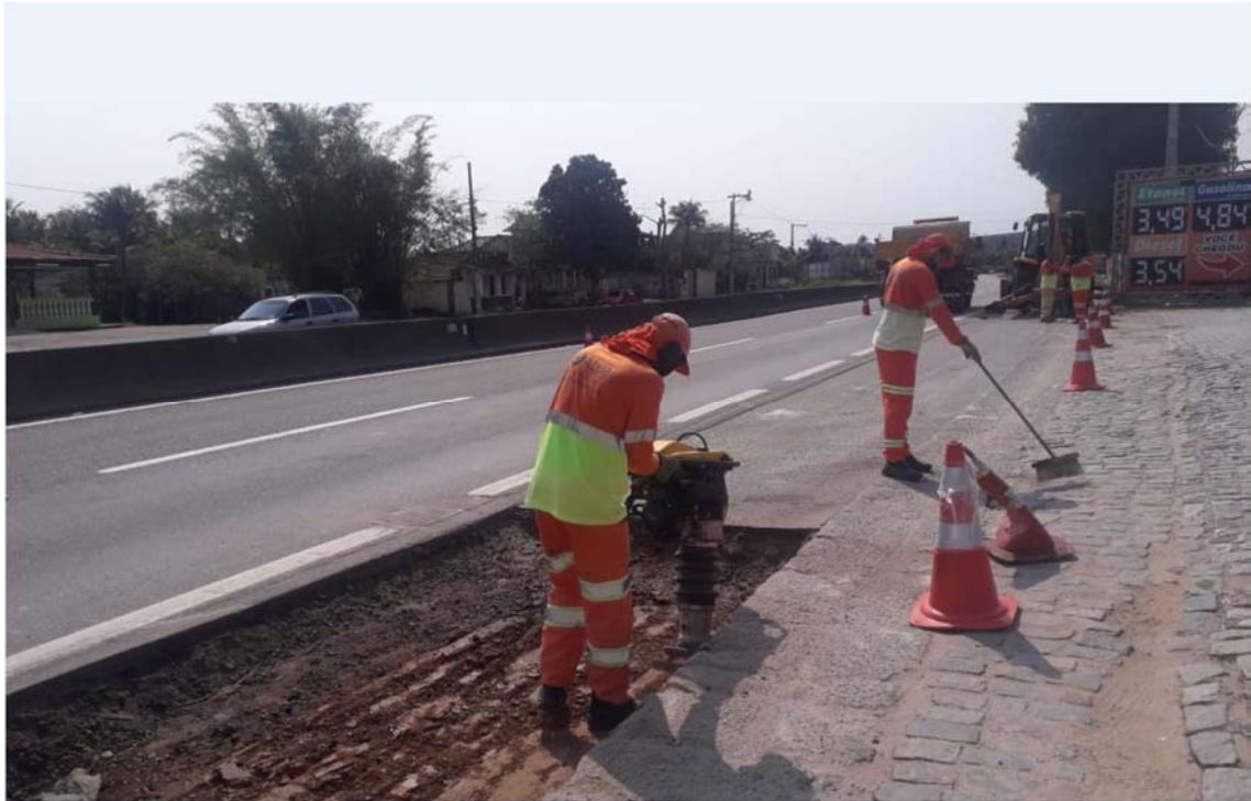
FOTO 01 – Acostamento – Reparo profundo - KM 13+500 Norte - F1
