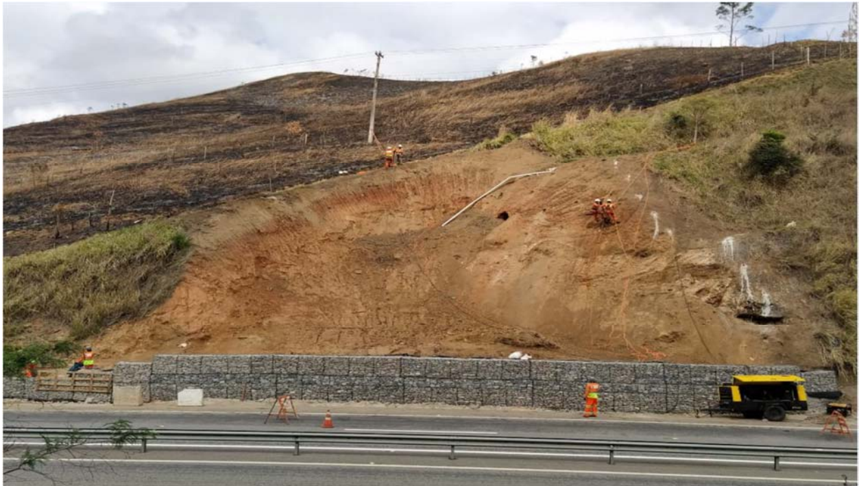
FOTO 21 – Obra de Recuperação de Talude Km 9+760 – F1
