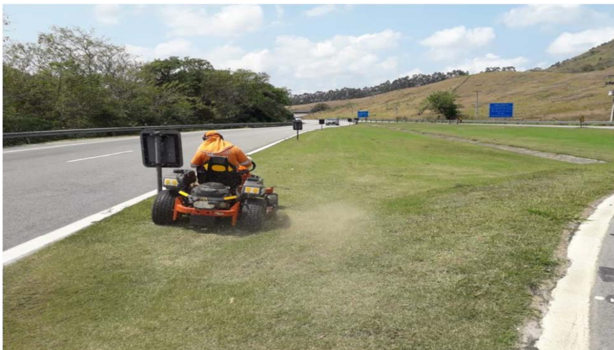
FOTO 18 – Roçada mecânica Km 20+300 Sul – F2
