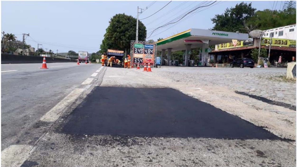
FOTO 03 - Acostamento – Reparo profundo - KM 13+500 Norte – F3
